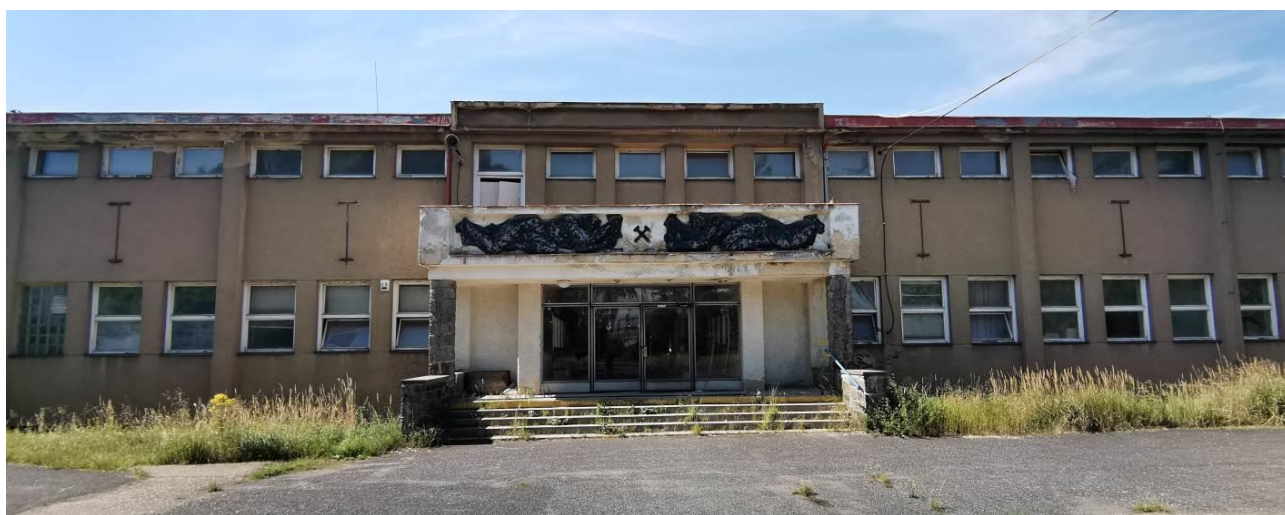
Obr. 2 Správní budova v areálu bývalého Dolu Centrum (12.8.2023).
